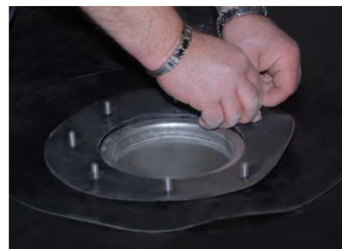
▲ Sorgfalt ist bei der Ablaufabdichtung geboten: Die Abdichtung wird hier zwischen zwei Zulagen aus Bahnenmaterial eingeflanscht
