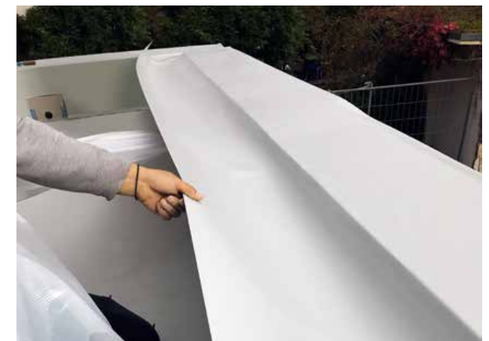
▲ Diese Detailbahnen lassen sich schnell verlegen, sodass wechselnde Wetterverhältnisse nur selten ein Problem darstellen
