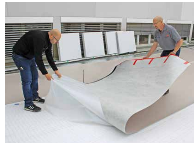
▲ Selbstklebende Kunststoffabdichtungsbahnen ermöglichen dem Dachdecker sauberes und wirtschaftliches Arbeiten
