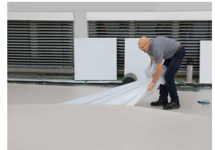
▲ Ein weiterer Vorteil selbstklebender Kunststoffbahnen ist die sofortige Windlastsicherung durch die flächige Verklebung
