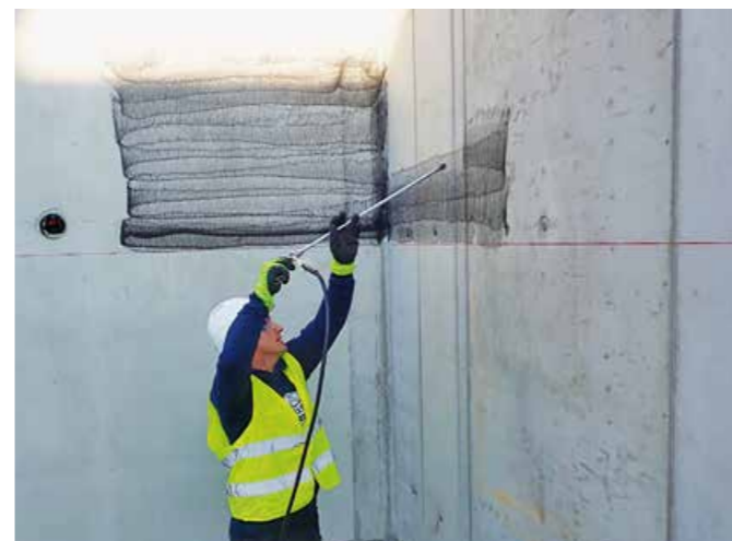
▲ Wand- und Sockelabdichtung mit einer Elastomerbahn: Ein Primer wird zunächst auf dem vorbereiteten Betonuntergrund aufgetragen
