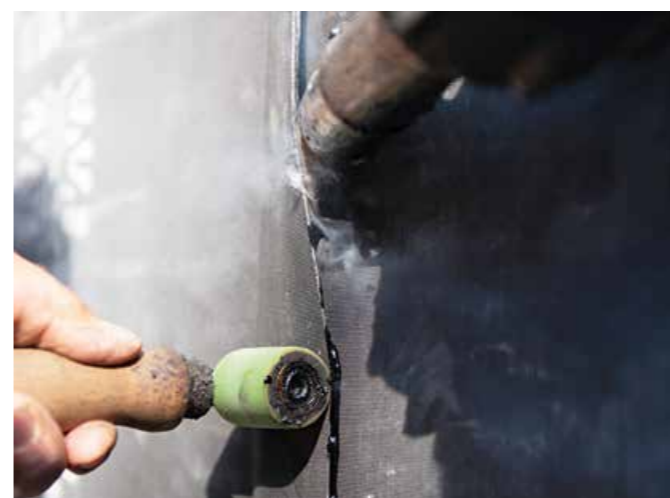
▲ Mit der Heißluftverschweißung lassen sich alle Längs- und Quernahtverbindungen fügen, wobei eine Schweißraupe austritt
