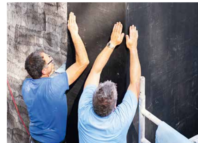
▲ Die selbstklebende EPDM-Dichtungsbahn muss im Wand- und Sockelbereich standfest und abrutschsicher verlegt werden
