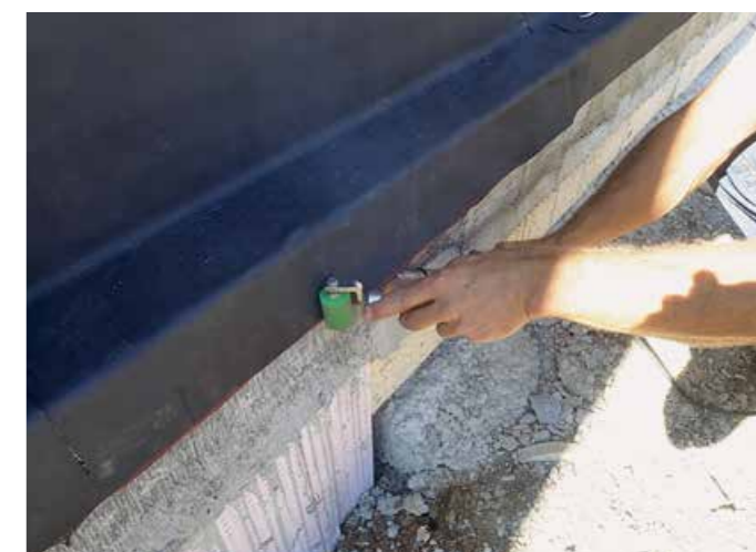
▲ Durch das Aufschweißen auf die zuvor geglättete Stirnseite wurde hier der Übergang zur Bodenplatte aus WU-Beton hergestellt
