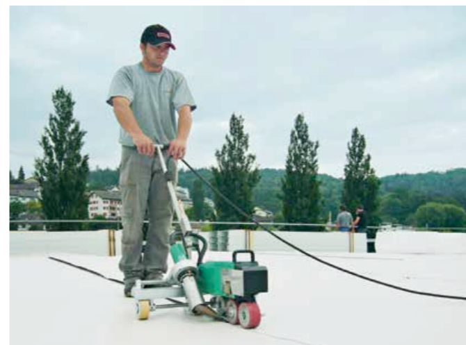
▲ Sichere Nahtverbindung: Die einzelnen Kunststoffbahnen dürfen bei einem Gründach nur per Heißluftschweißung gefügt werden
