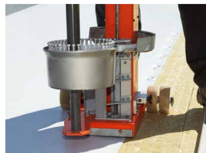
▲ Mechanische Befestigung in einem Arbeitsgang: Setzautomat für die schnelle Verarbeitung von magazinierten Befestigern
