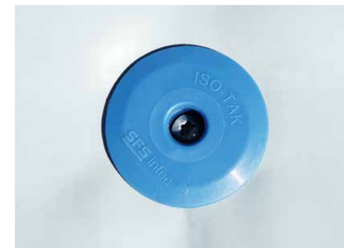
▲ Hier wurde die mechanische Befestigung mit einem Befestiger mit runder Kunststofffülle ausgeführt
