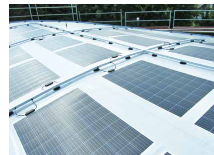
▲ Dachintegrierte PV-Anlage: Die systemgebundene Verlegung der Kabel erfolgt mithilfe spezieller Kabelkanäle
