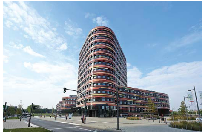
Bild 3. Die 16.000 m 2 große, z. T. begrünte Dachfläche der Behörde für Stadtentwicklung und Umwelt in Hamburg ist teils mechanisch befestigt, teils geklebt (Fotos: DUD und Mitgliedsunternehmen)
