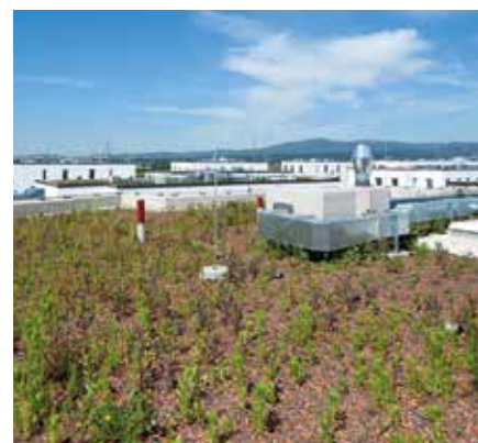
Dachbegrünung einer Wohnhaussiedlung in Frankfurt
