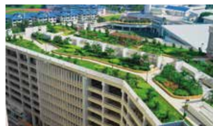
Intensive Dachbegrünung mit Baumbepflanzung
