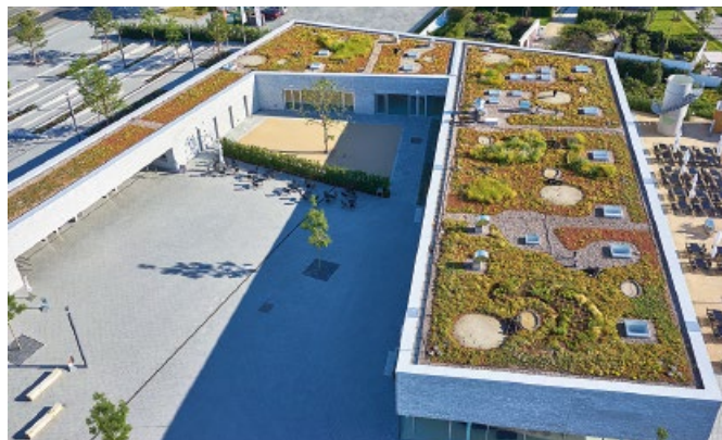
Bild 9. Starke Grundlage für dauerhafte Sicherheit: Kunststoffdachbahnen bieten sich als Abdichtung unter einer Dachbegrünung an. (Fotos 1, 5–9: DUD und Mitgliedsunternehmen)
