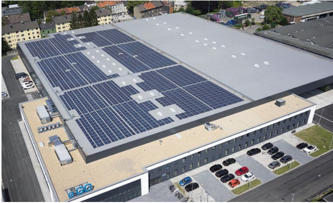
Bild 5. Das Dach als Kraftwerk: Die Abdichtung aus Kunststoffdachbahnen kann auch als Grundlage für eine PV-Anlage dienen.
