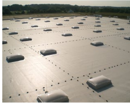
Bild 7. Anschlüsse, Durchdringungen und Details lassen sich mit Kunststoffdachbahnen einfach und langfristig sicher ausführen.
