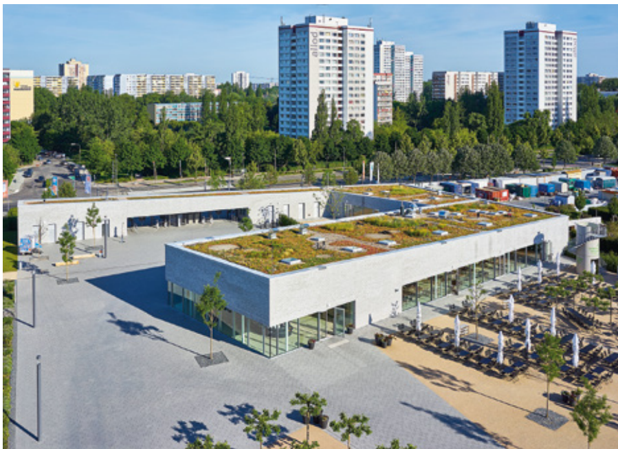
Bild 1. Der „Garten der Welt“ in den „Gärten der Welt“ in Berlin-Marzahn zeigt, was in der Dachbegrünung möglich ist
