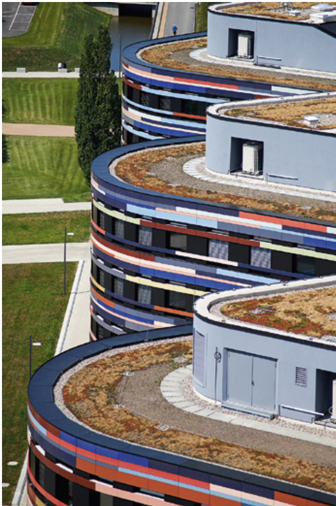
Bild 4. Dachabdichtungen aus Kunststoff, wie hier beim Hauptsitz der Behörde für Stadtentwicklung und Umwelt (BSU) in Hamburg, sind flexibel an verschiedenste Formen anpassbar und zuverlässig dicht
