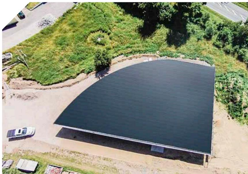
▲ Dieses außergewöhnliche Dach einer Bootswerft in Bordesholm wurde mit PVC-Bahnen abgedichtet
