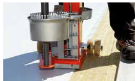
Mechanische Befestigung mit dem Setzautomaten.
