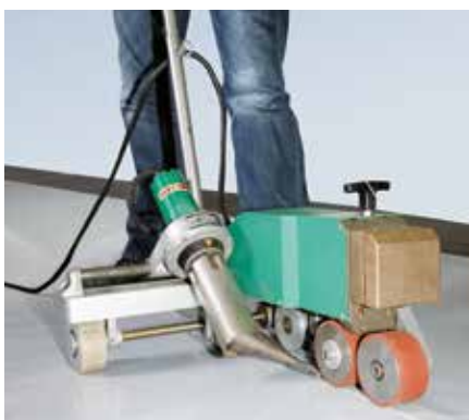
04 Heißluftschweißen ohne offene Flamme
