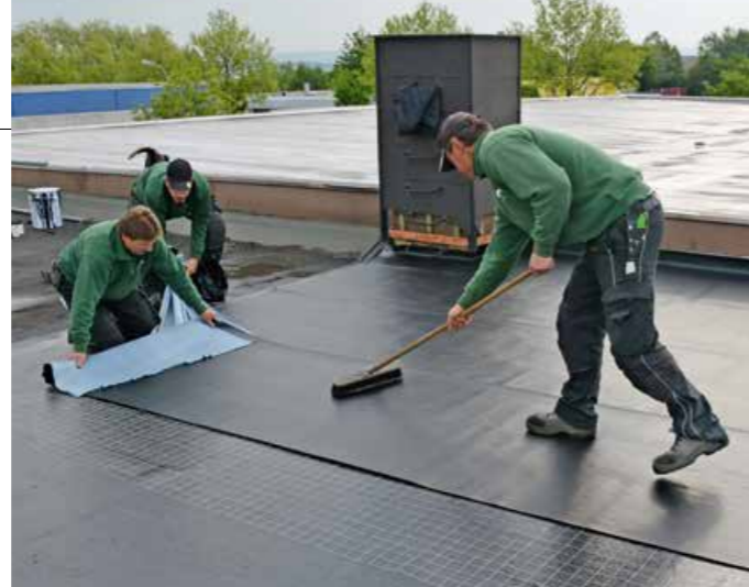
▲ Verlegung einer Kunststoffbahn mit werkseitiger Selbstklebebeschichtung
