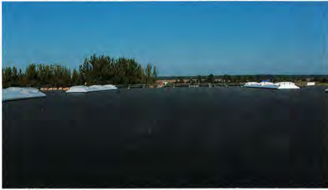
Bild 3. Kunststoffbahndach einer Logistikhalle in Gießen
