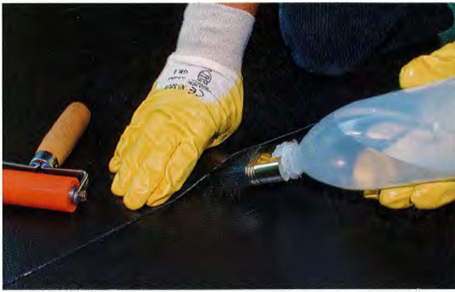
Bild 6. Nahtverbindung durch Quellschweißen (Fotos: DUD e. V.)
