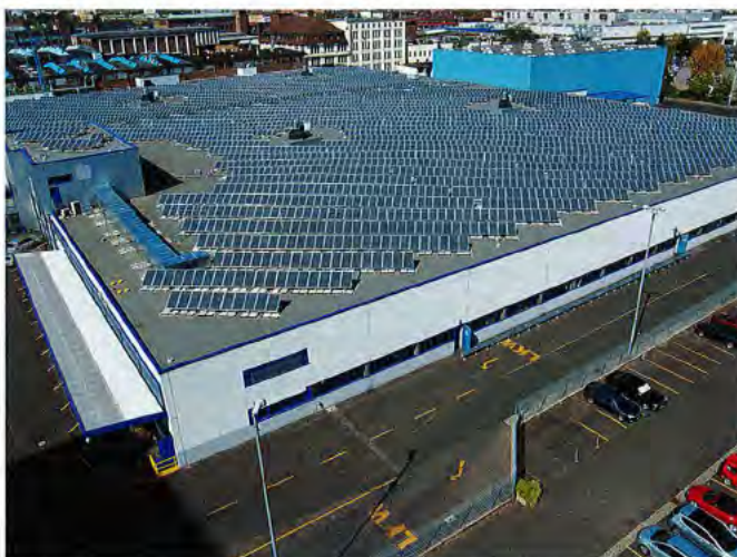
Bild 4. Kunststoffdachbahnen sind als Abdichtung unter Solaranlagen geeignet, wie diese Werkhalle veranschaulicht
