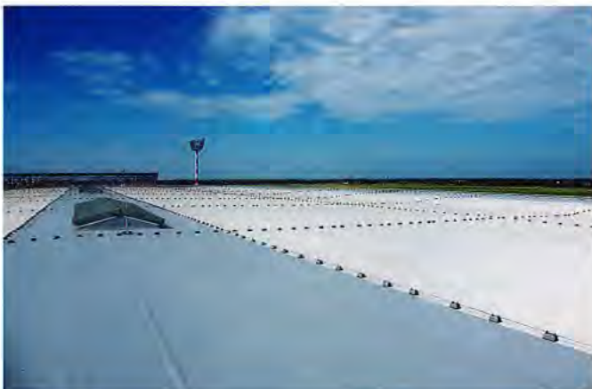
Bild 1. Flachdach mit Kunststoffdachbahnen auf der LTU Halle am Flughafen Düsseldorf
