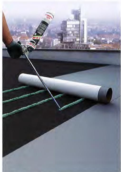
Bild 5. Verkleben einer Kunststoffdachbahn mit produktbezogenem Systemklebstoff
