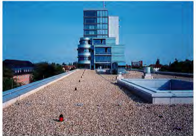
Bild 2. Bürogebäude Vattenfall, Cottbus: Die Kunststoffdachbahnen wurden bekieselt.
